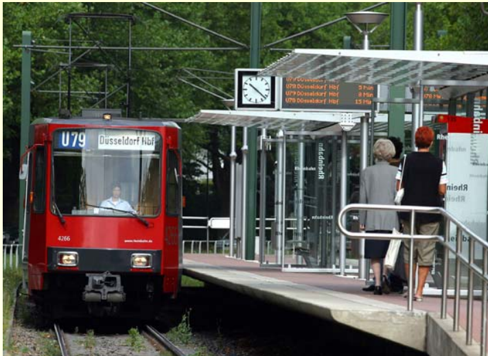
Beispiel einer Neuanlage
