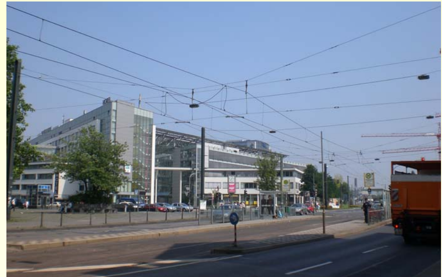
Die vorhandene Fahrleitungsanlage ist umzubauen.
