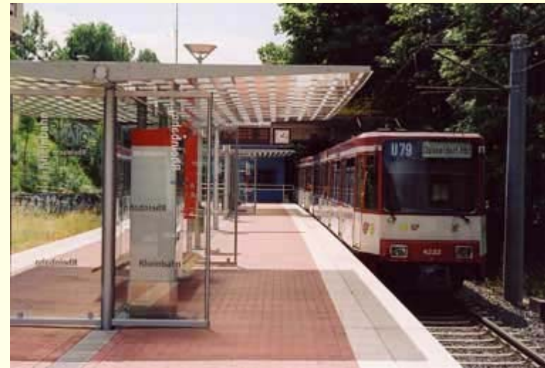
Bereits vorhandene Hochbahnsteiganlage der Linie U79
