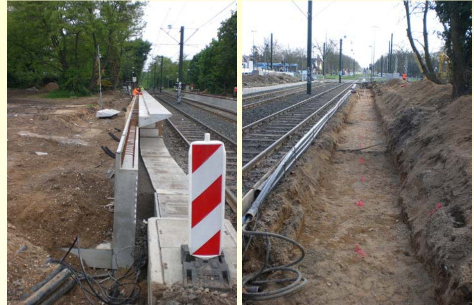
Bilder vom Bau der Hochbahnsteiganlage Freiligrathplatz
