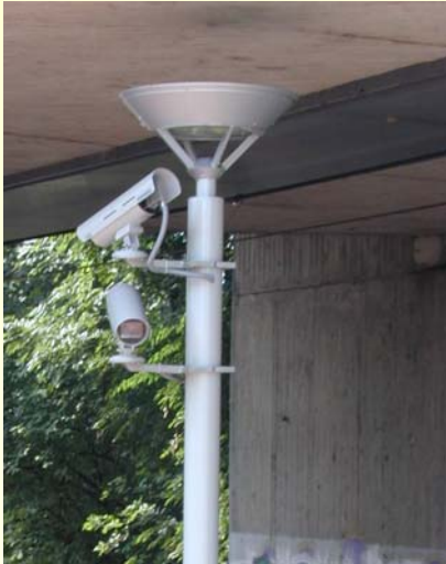
Anordnung von Kameras am Beleuchtungsmast
