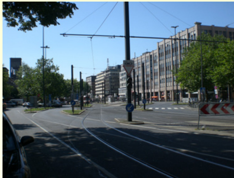
Gelb-Rot-Anlage des querenden IV
