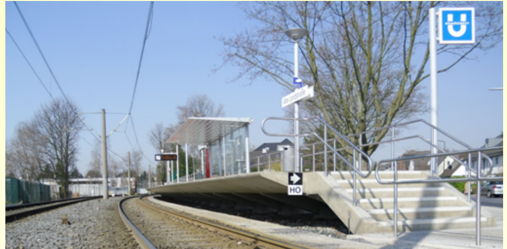
Hochbahnsteig nach dem Umbau
