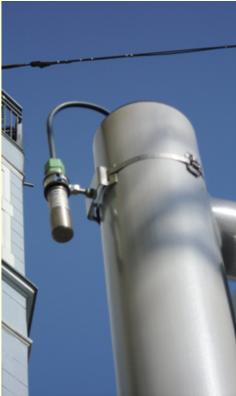
Temperaturfühler Weichenheizung
