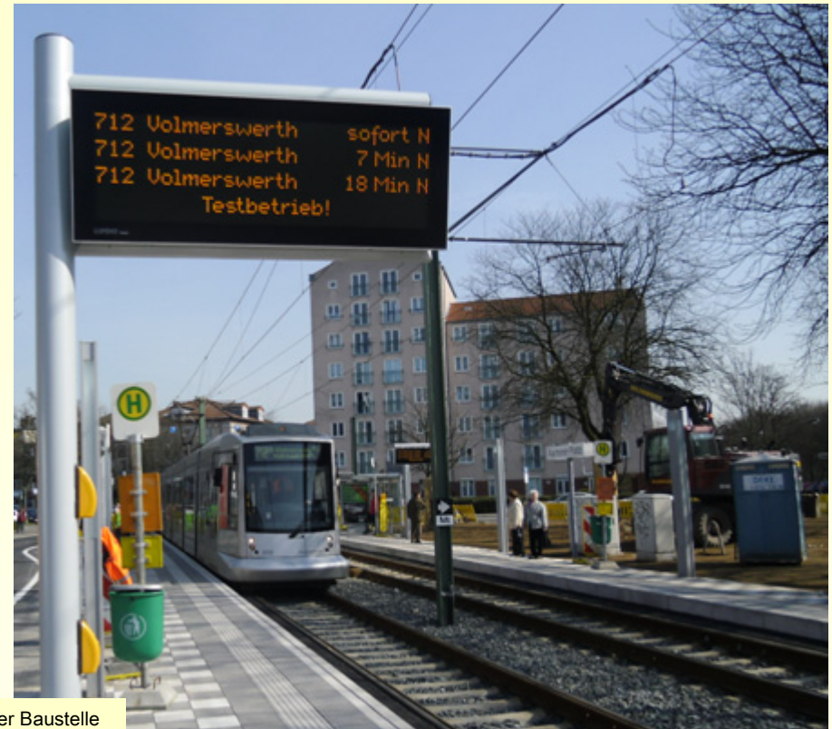
Bilder von der Baustelle
