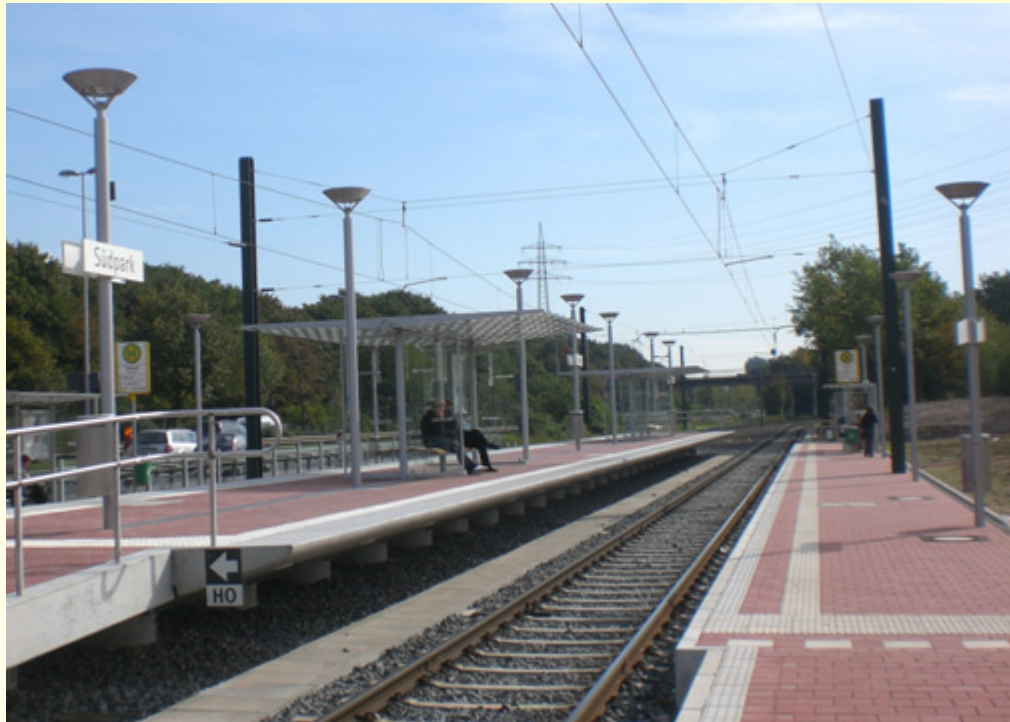
neu gebaute Hochbahnsteiganlage
